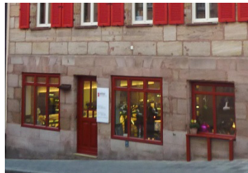
-Nachher- durch einen Fensteraustausch
