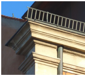
Traufgesims in Sandstein
