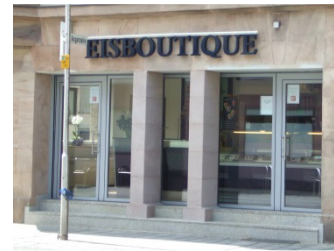
... oder mittels Mauerpfeiler
