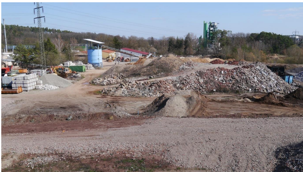
Abb. 6: Betriebsgelände, vom Deponiehügel aus fotografiert. Blickrichtung O.
